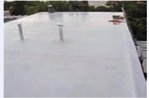
Εφαρμογή Neorooft ® σε δώμα με λιμνάζοντα νερά
